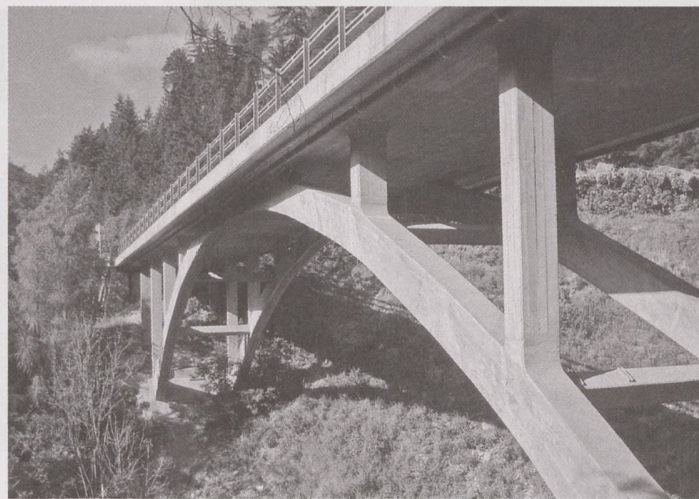
Alexandre Sarrasin: Pont sur le Laxgraben, Lax (1941–1942).
