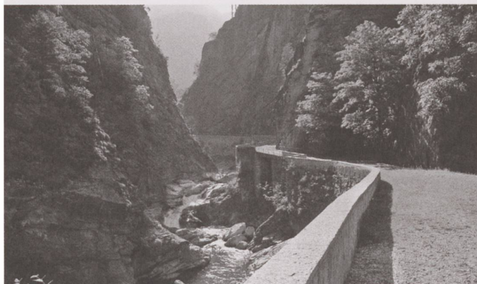
Erhalten dank touristischer Erschliessung: ViaGottardo. Die Kantonsstrasse aus dem 19. Jahrhundert in der Piottinoschlucht.
