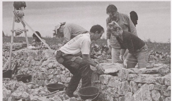
Kein Gramm Mörtel: Trockenmauerbau auf dem Probstenberg (Region Thal).
