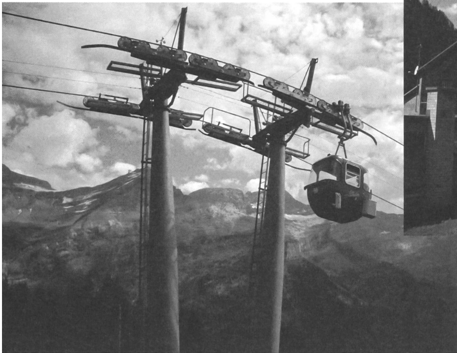
Einseil-Umlaufkabinenbahn Les Diablerets-Isenau, Les Diablerets (VS), von Giovanola Frères (1974). Stűtze und Fahrzeug.
