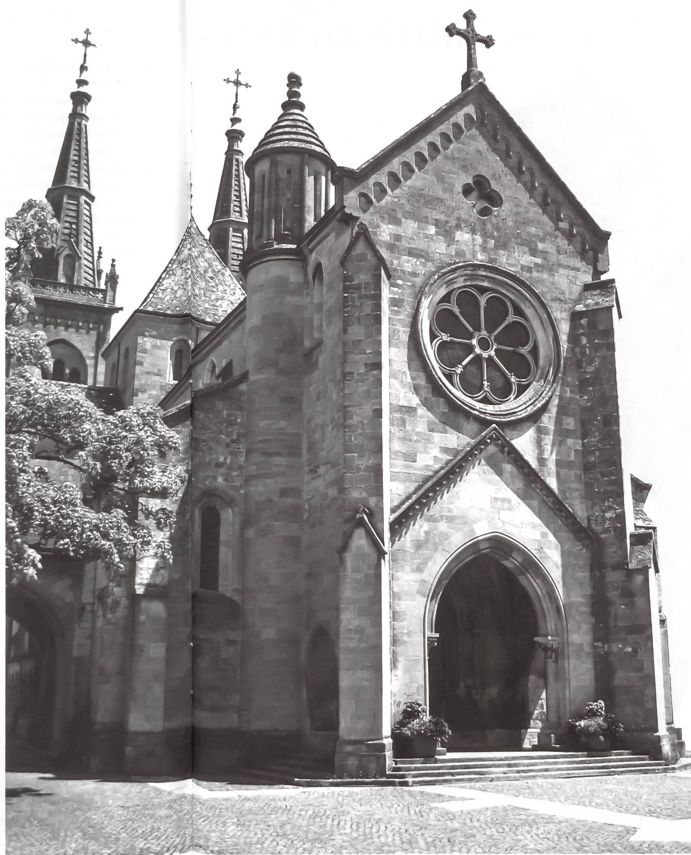
Façade ouest de la Collégiale de Neuchâtel en Pierre Jaune de Neuchâtel. Les escaliers sont en grès coquillier burdigalien de la Mollière (FR).
