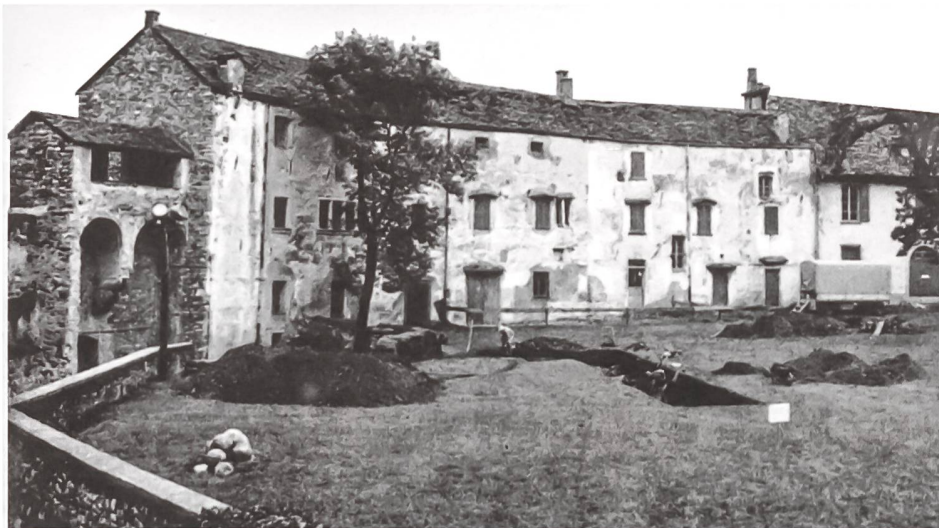
Bellinzzone, Castelgrande: cour et bâtiments avant rénovation.
