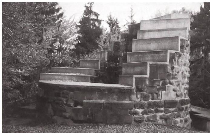
turm von Lieli (LU; links) musste nicht nur das Wasser so vollständig wie möglich abgeleitet werden, sondern es waren zudem die abgelösten Mauermäntel zu verklammern. Das versuchte man letztes Jahr mittels einer rinnenförmigen armierten Betonplatte zu bewerkstelligen.
