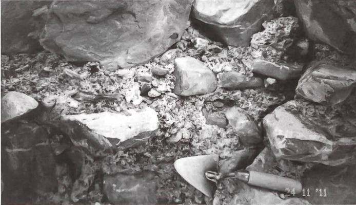
feinkörnige Mörtel finden. Am Castello von Mesocco (GR) überlagern sich nördliche und südliche Einflüsse in der Art, dass auf der eigentlichen Burg in allen Epochen feinsandige Mörtel verwendet wurden, die massiven nordöstlich vorgelagerten Mauerzüge aber mit grobkörnigem Mörtel aufgeführt sind.
