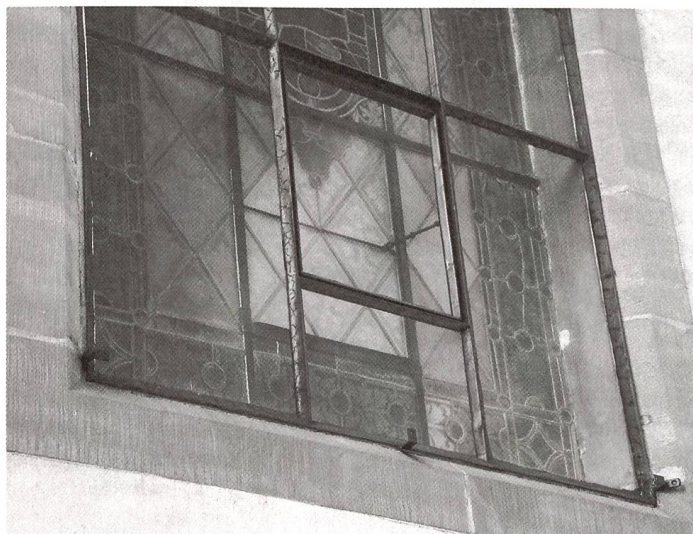
Einfache vorgesetzte Aussenschutzverglasung mit Lüftungsflügel in Metallrahmen in der Kapuzinerkirche in Romont (FR) von ca. 1950. Aufnahme kurz nach der Restaurierung.
