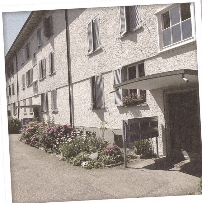
Schlichte Fassaden prägen die Siedlung.
