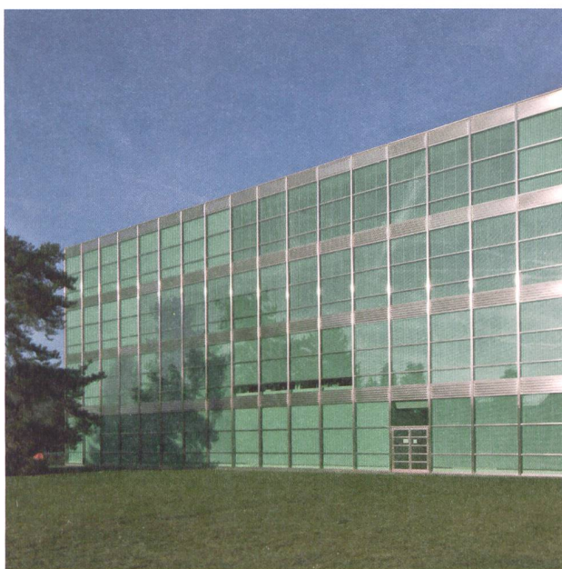
Hochschule für Technik FHNW in Windisch, 1964–1966 von Fritz Haller.
