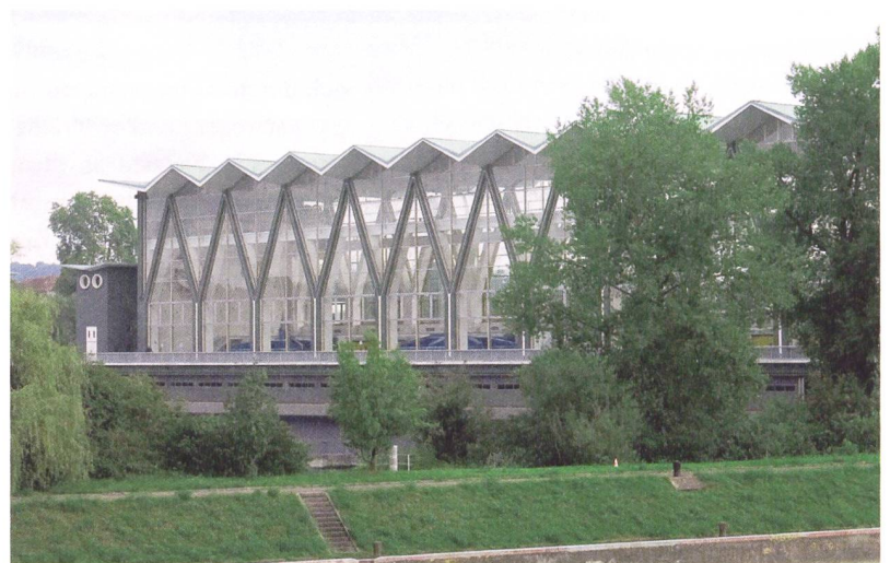
Kraftwerk Birsfelden, 1955 von Hans Hofmann.
