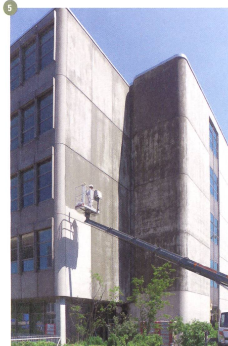
Abb. 5: Lenzburg, Hauptgebäude der Berufsschule: Reinigung der Sichtbeton- fassade, 2015.
