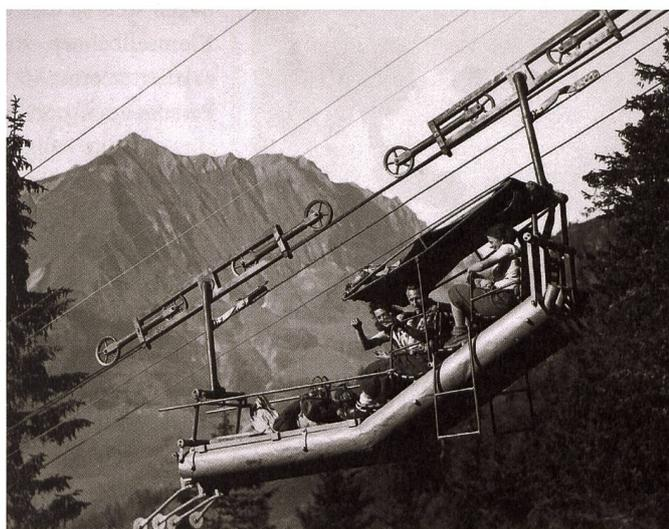
Die Luftseilbahn Dallenwil – Wiesenberg wurde ebenfalls von NSD Niederberger erbaut. Ungewöhnlich ist, das unter der Kabine und Ladebrücke geführte Zugseil. Foto 1935.
