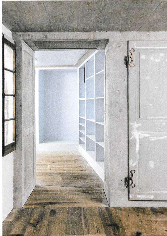
Blick ins Ateliergeschoss. Auf der neuen Betonwand ist eine alte Tür rahmenlos aufgesetzt.
