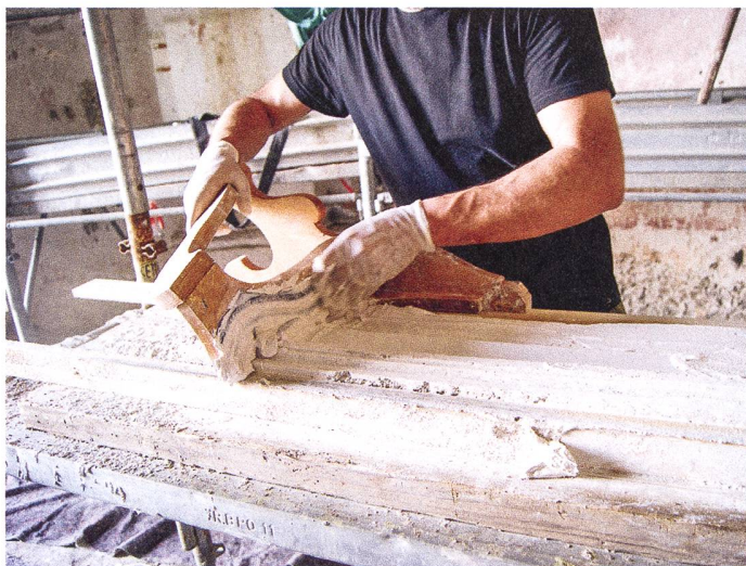
Esecuzione di una cornice in stucco con il modine © SUPSI, 2018
