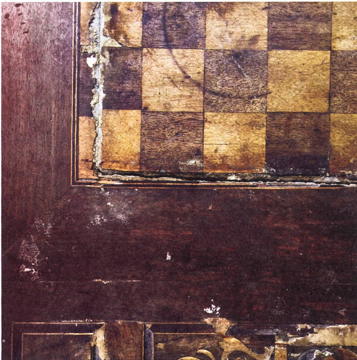
1: Schach-Tischchen; Veronika Müller. Das originale Schachbrett, welches anders als die seitlichen Intarsien aufgrund einer Fehlkonstruktion nicht sinnvoll repariert werden konnte, ist in der Schublade im Tisch unter Glas konserviert und durch ein neues, richtig konstruiertes Schachbrett ersetzt worden.
