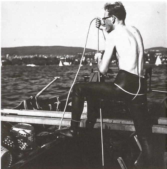
Abb. 12: Ulrich Ruoff am Haumesser beim Einschlagen der Boden-sonde vom Schiff aus, 1966. © AFS
