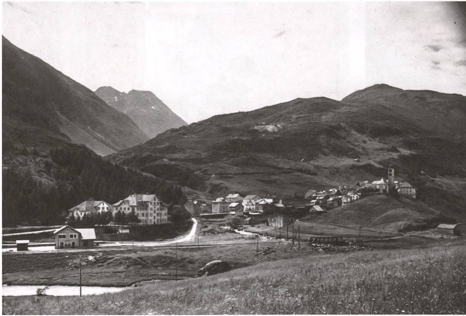
Das historische Stationsgebäude von Hospental (links im Bild), aufgenommen zwischen 1890 und 1934, soll nicht einem Werkstattneubau der Matterhorn-Gotthard-Bahn weichen.
