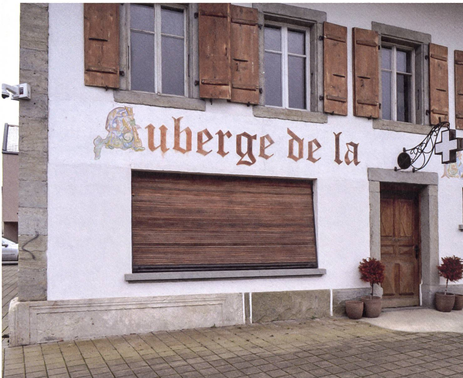
Fig. 3 et 4 : Pilastre en calcaire urgonien en emploi dans l'angle nord-est de l'Auberge de la croix blanche à Domdidier. © Philippe Baeriswyl, SMRA
