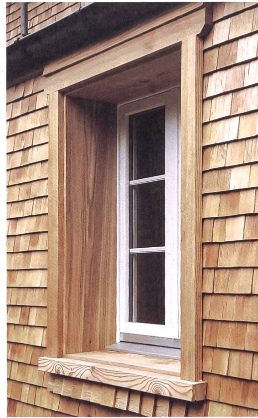
In Zusammenarbeit mit einem lokalen Handwerker und im Austausch mit der kantonalen Denkmalpflege hat der Eigentümer die Fenster und die Fassade weitgehend eigenhändig erneuert. © Denkmalpflege Appenzell Ausserrhoden
