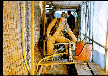
Abb. 18 Verfüllen der Klüfte mittels Injektionen
