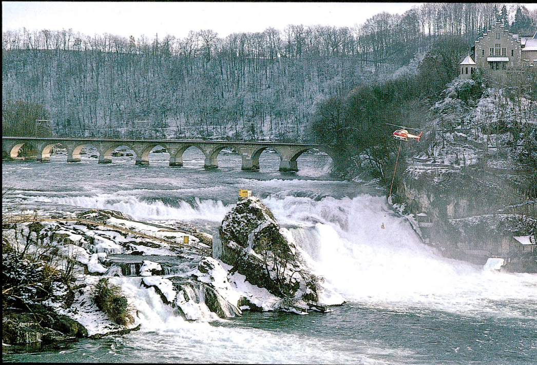
Abb. 13 2. Helikoptereinsatz zur Verstärkung der Sandsackdämme
