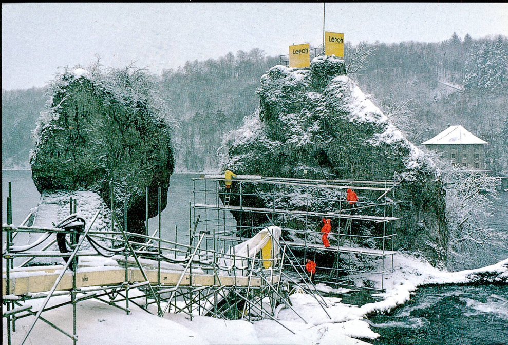
Abb. 10 Bau von Steg und Arbeitsgerüst
