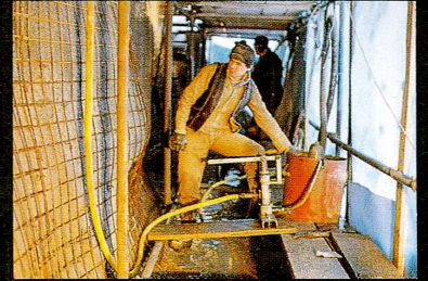
Abb. 18 Verfüllen der Klüfte mittels Injektionen
