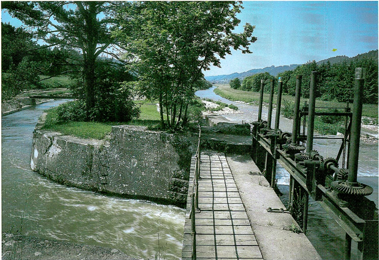
Abb. 35: Der Einlauf in den zum Kraftwerk Wunderklingen führenden Kanal.
