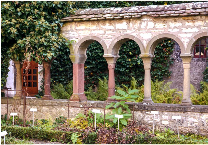
Abb. 103: Einzelne rote Säulen im Kreuzgang des Klosters Allerheiligen bestehen aus rotem Schilfsandstein.
