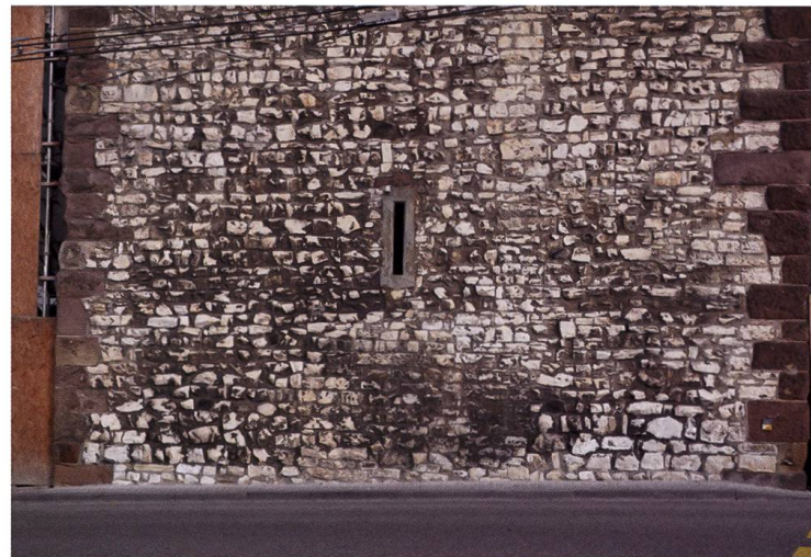
Abb. 102: Am Obertorturm erkennt man eine ganze Reihe von Bausteinen: Kalkstein aus der Umgebung der Stadt, Schilfsandstein aus dem Klettgau, Bollensteine aus dem Rhein und Plattensandstein aus dem Bodenseegebiet.
