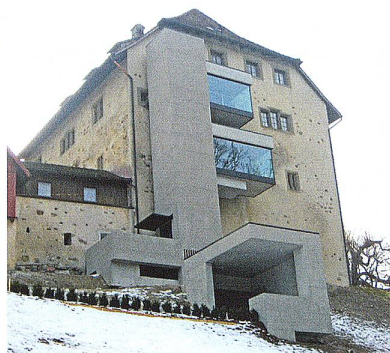
Das Schloss Oberberg von Nordosten mit dem Liftschacht und den zwei Glaspasserellen.
