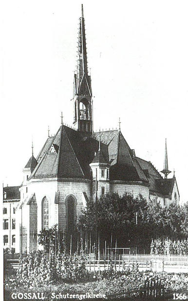
Die Schutzengelkirche aus Nordosten. Im Vordergrund der Gemüse- und Blumengarten der Lehrschwestern aus Ingenbohl.
