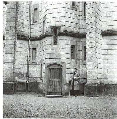
Seitliche Eingangstüre zur Schutzengelkirche. Oberhalb der Türe wurde der Grundstein angebracht, in den die Jahrzahl 1890 eingemeisselt wurde.
