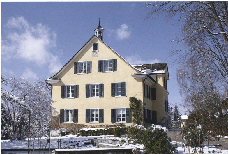
Haus im Park, Ansicht von Osten.
