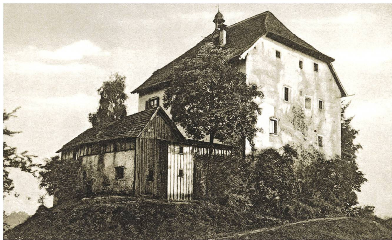
Defekte Nordmauer und WC-Anbau Söldnerhaus
