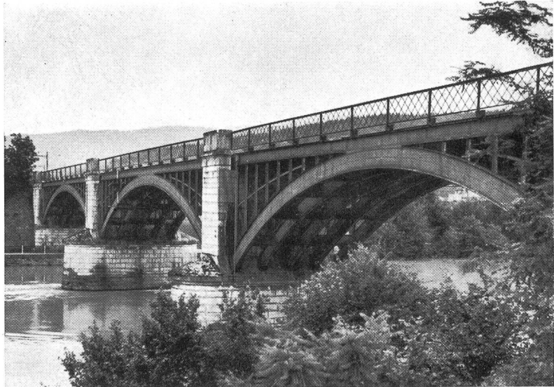
Bild 5 Erste Eisenbahnbrücke über die Aare bei Olten 1857 (erbaut von der Hauptwerkstätte der SCB. in Olten)
