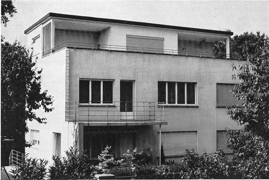
Frey und Schindler, Wobnbäuser Wiesenstrasse in Olten , 1932 Erste Flachdachbauten in Olten. Kubische, flächige Erscheinung. Beschränkung der gestalterischen Mittel auf die allernotwendigsten Elemente. Nutzung der Dachterrasse.
