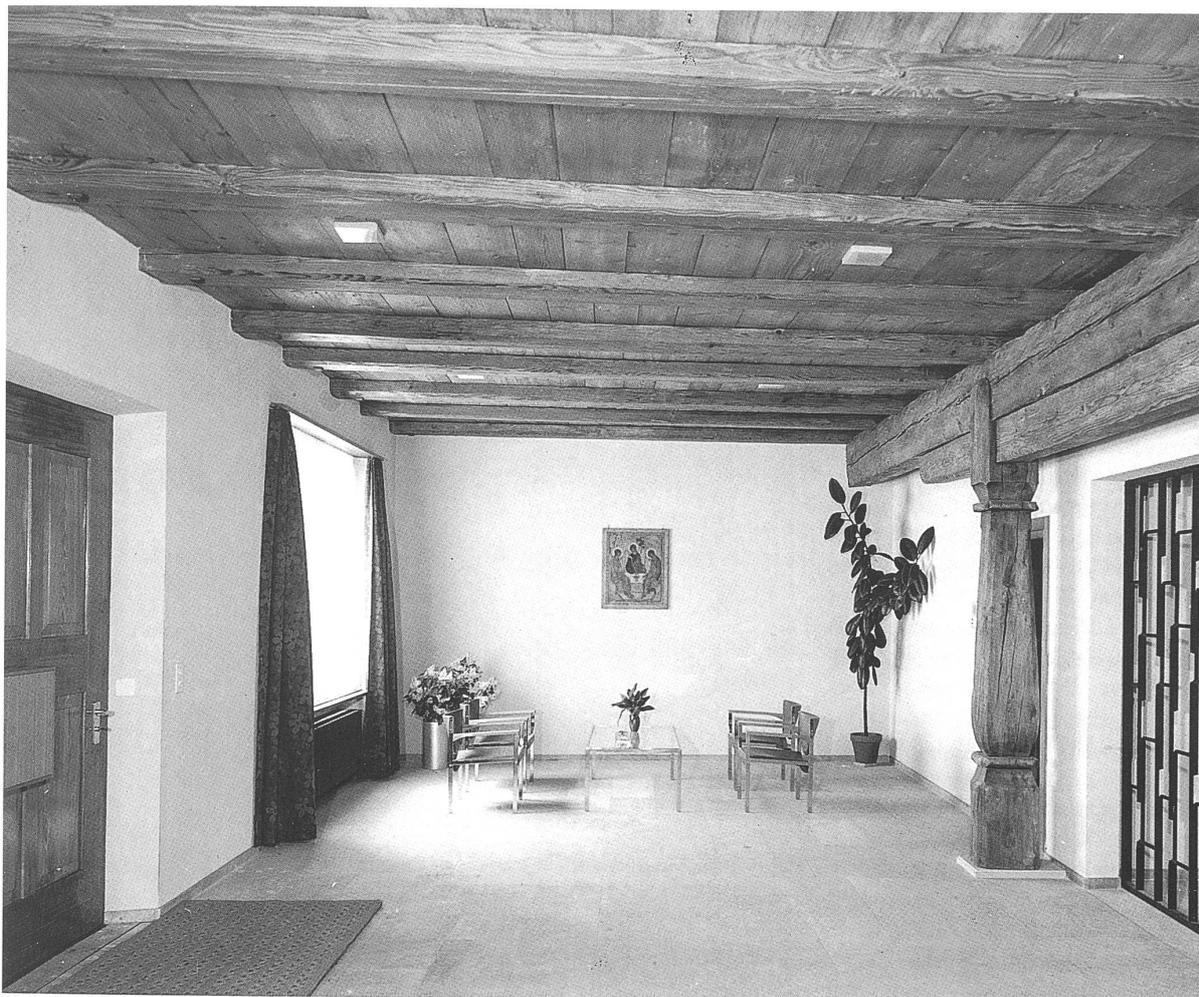
△ Diese beeindruckende Balkendecke mit der schweren Tragkonstruktion befand sich ursprünglich auf der «Kornschütte» im Estrich der Chorherrenhäuser. Sie wurde 1968 anlässlich des Gesamtumbaus des christkatholischen Pfarrhauses ins Entree im Erdgeschoss verlegt.
