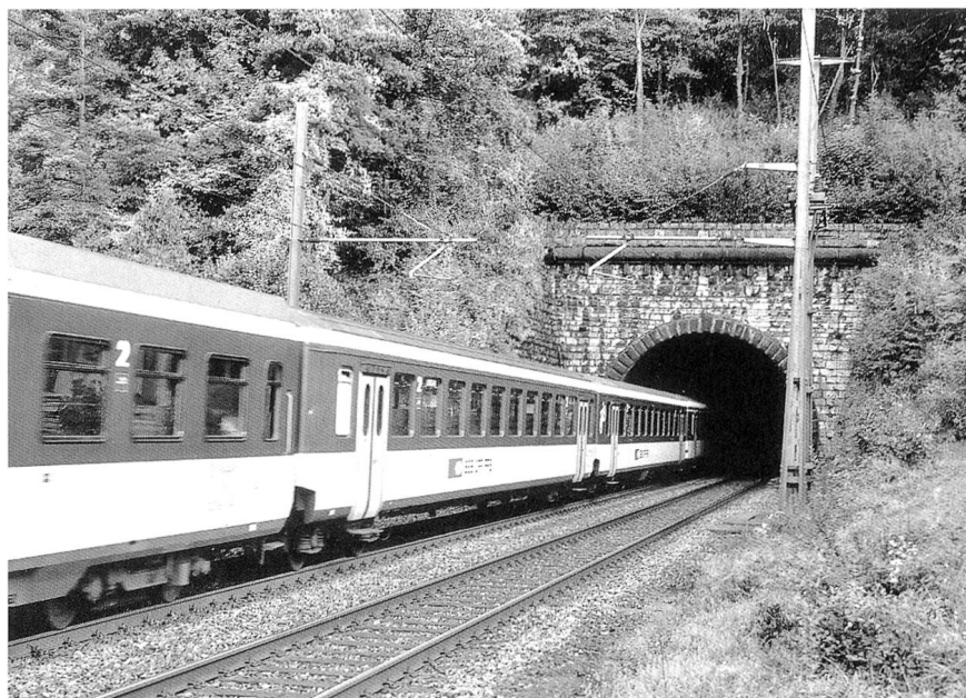
Das Südportal des Hauenstein-Basistunnels
