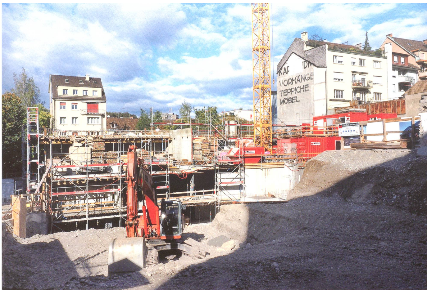
An der Ecke Unterführungs-/Von-Roll-Strasse entsteht bis Frühling 2016 das Wohn- und Geschäftshaus «Aarepark».
