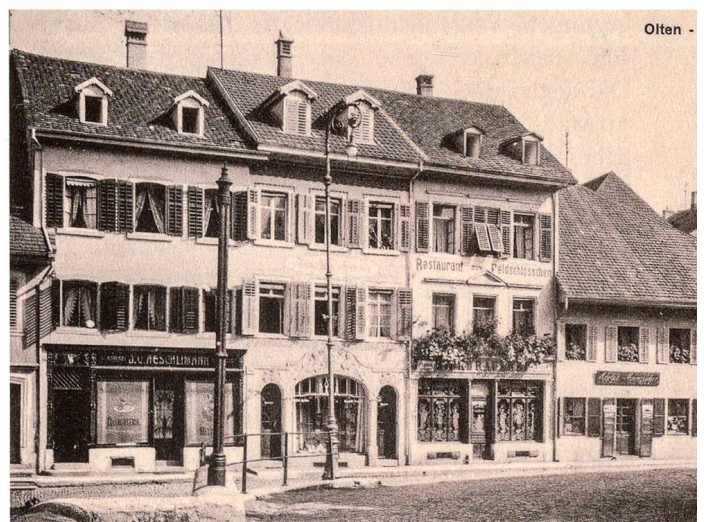
4. Häuserzeile im «Winkel» mit dem Restaurant Feldschlösschen (ehem. Brauerei [Studer]), VD 15.4.1920, ohne HV. Etwas zurückversetzt das ehem. Restaurant Klosterbräu
