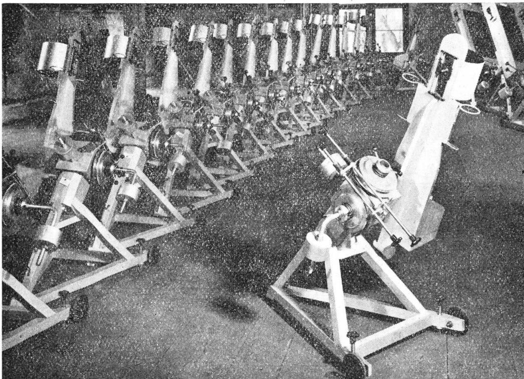
Montierung — bestimmt für den Einbau von 15 cm-Spiegeln — ist transportabel und mit Feinbewegung in Stunde und Deklination versehen.
