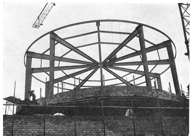
Stahlkonstruktion des Planetariumszylinders.
