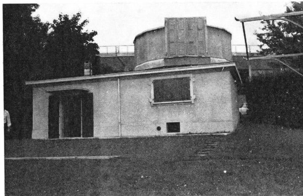
Nouvel observatoire de la SVA, diamètre de la coupole 5.5 m.
