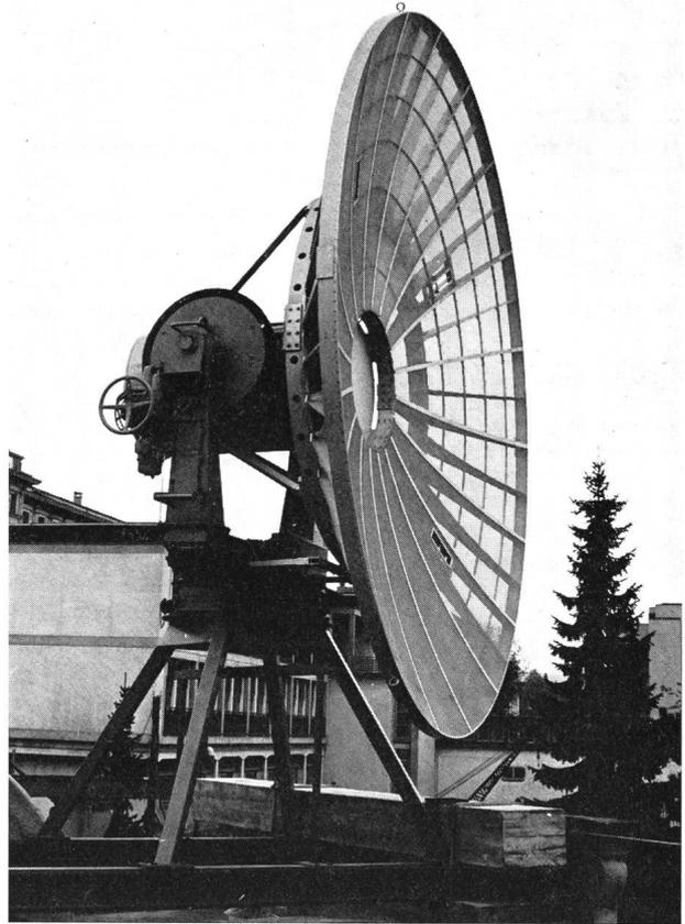
Parabolreflektor des ETH-Radioteleskops ohne Primärstrahler.
