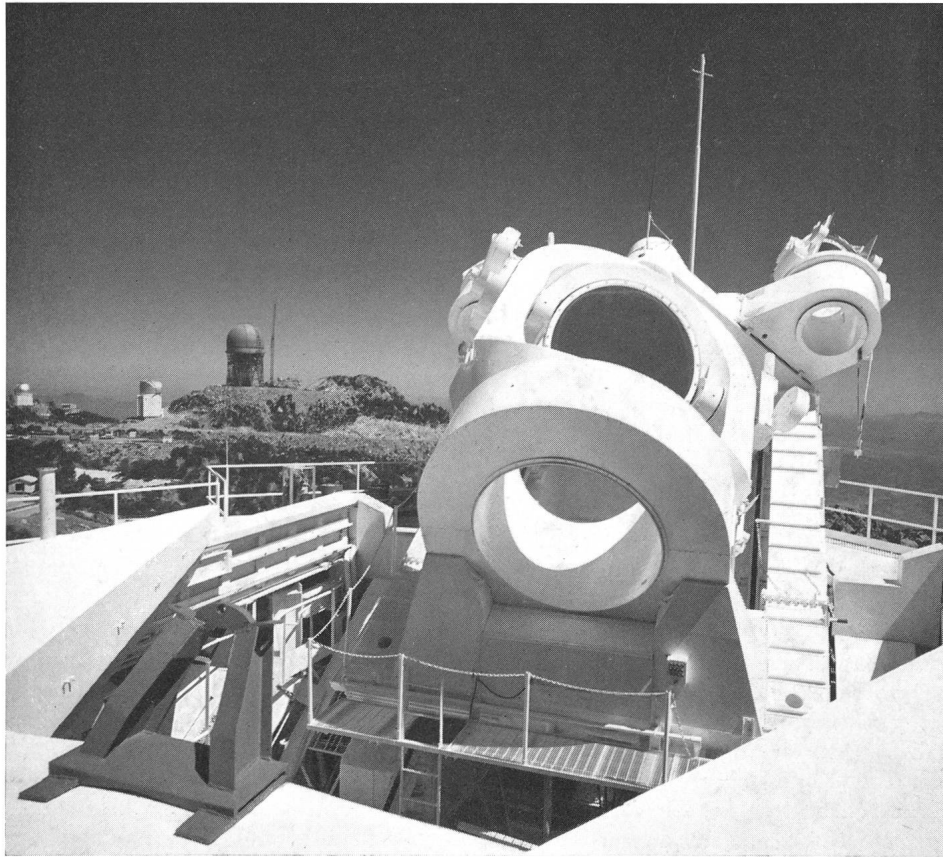
Bild 1: Der Heliostat des Sonnentelops von Kitt Peak, dessen 200 cm-Spiegel das Sonnenlicht in den Lichtschacht und auf den Hauptspiegel vom 150 cm Durchmesser wirft. Am Heliostaten sind noch zwei kleinere Hilfs-Heliostaten angeordnet, die in Verbindung mit entsprechenden abbildenden Systemen Überwachungs- und Kontrollzwecken dienen. Kitt Peak Nat. Obs. Photograph 8122.
