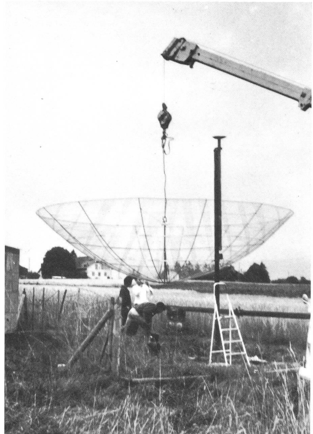
Fig. 1: Le réflecteur parabolique en cours de montage.
