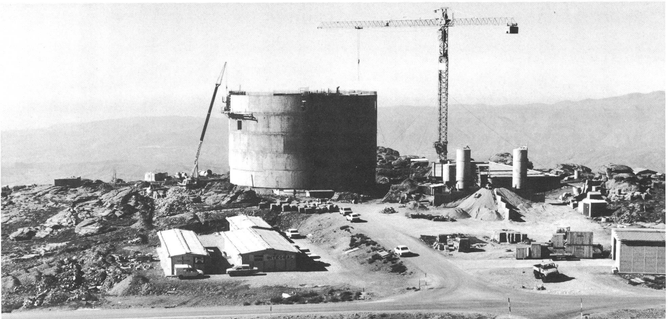
Abb. 2: Stand der Bauarbeiten am Kuppelbau für das 3,5 m-Teleskop im Herbst 1979.
