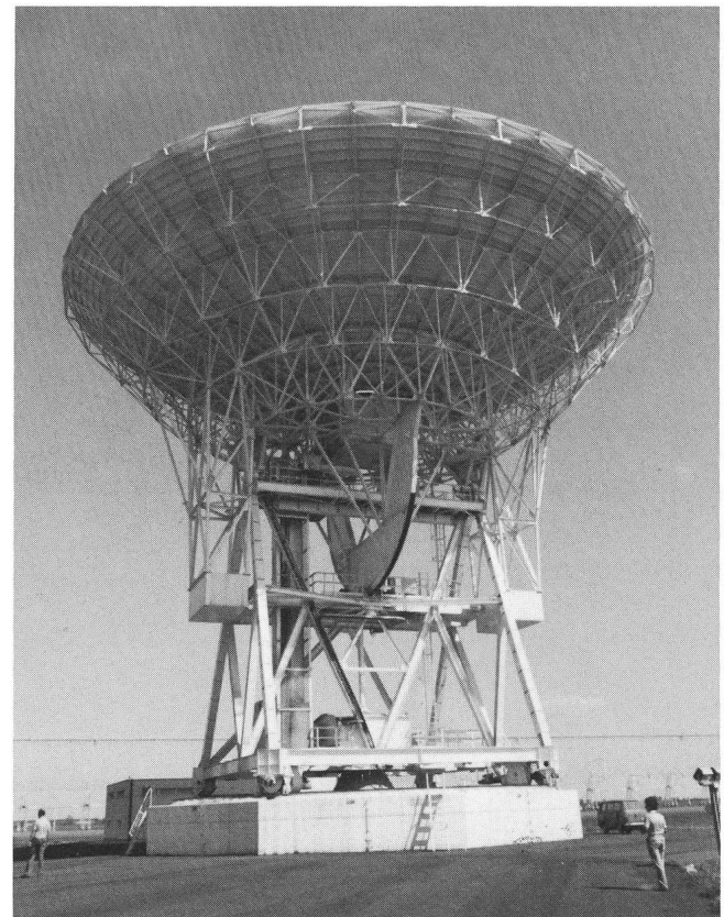
Abb. 5: Der grosse Parabolspiegel «VLBI» von 32 m Durchmesser in Medicina. Im Hintergrund der Ost-West-Arm vom «Kreuz des Nordens».
