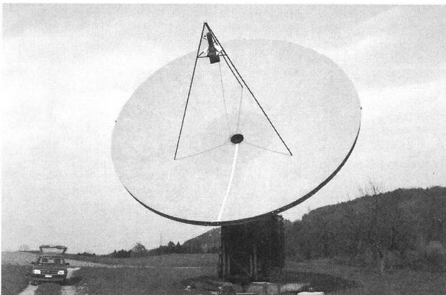
mit einem Durchmesser von  $D = 10$  m bei Ermenswil am Rickenpass [3] hat näherungsweise folgenden theoretischen Gewinn  $G$  bei einer Empfangsfrequenz  $f = 435$  MHz
