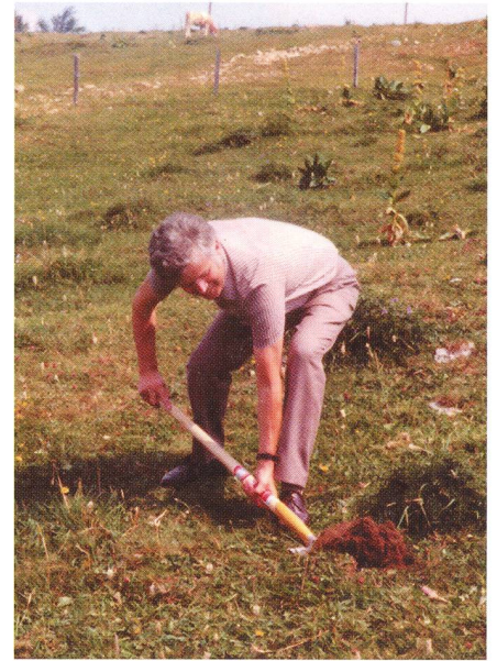
9. August 1975: ERICH WOLF beim ersten Spatenstich für den Bau der Jurasternwarte.
