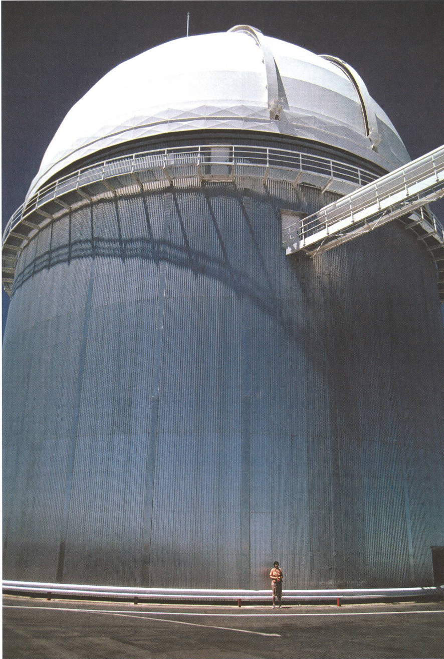
Fig. 14. La coupole du télescope de 3m60 (décembre 1986). Les télescopes modernes, bien que plus grands, occupent des coupoles moins volumineuses. Leurs montures azimutales et les techniques d'optique active autorisent des structures plus légères et compactes.
