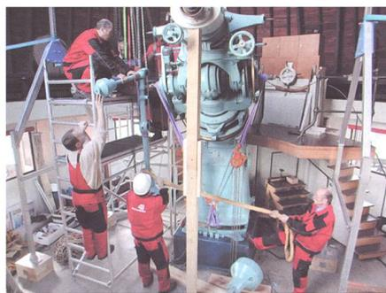
Fig. 9: Beginn der Demontage des Refraktors. In reiner Handarbeit und unter sorgfältiger Sicherung wurde die Montierung, deren Einzelteile teilweise mehr als 100 Kilogramm wiegen, abgebaut. Aufn.: AW
