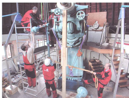
Fig. 9: Beginn der Demontage des Refraktors. In reiner Handarbeit und unter sorgfältiger Sicherung wurde die Montierung, deren Einzelteile teilweise mehr als 100 Kilogramm wiegen, abgebaut. Aufn.: AW
