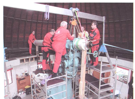
Fig. 10: Nach dem Entfernen des Objektivs begann die Demontage des Fernrohres. Dabei kamen, neben der detaillierten Registrierung, zahlreiche unentbehrliche Montagehilfen zum Einsatz. Aufn.: AW
