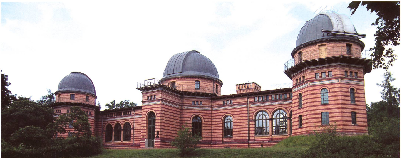
Figur 4: Das ehemalige Hauptgebäude des Astrophysikalischen Institutes Potsdam. Heute werden diese Gebäude vom Institut für Klimafolgenforschung genutzt. Sie sind Bestandteil des Wissenschaftsparks Albert Einstein. (Bild: Markus Griesser)
