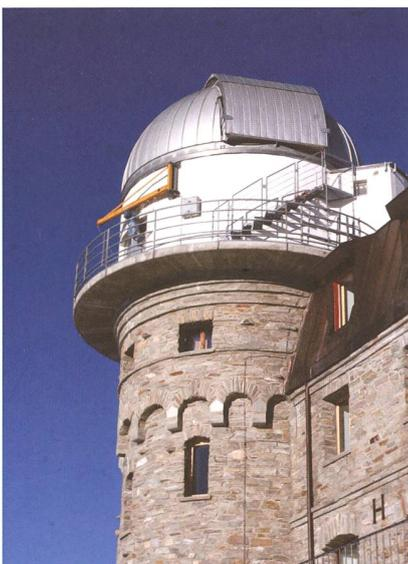
Die Aufnahme zeigt den Nordturm. Der Durchmesser der Kuppel misst 7.5 m. Sie ist innen mit Alu verkleidet, wie auf dem Bild mit dem Refraktor zu sehen ist. (Foto: Roland Schneider)
