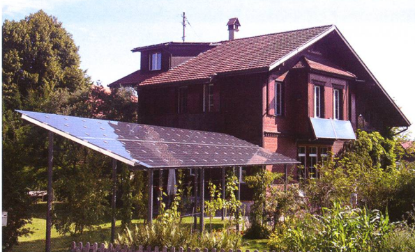
Abbildung 9: Die Solaranlage in Schwarzenburg liegt auf einer frei stehenden Metallkonstruktion im Garten. Diese deckt den Zugangsweg und wirkt wie eine Art Pergola. (Foto: Erich Laager)
