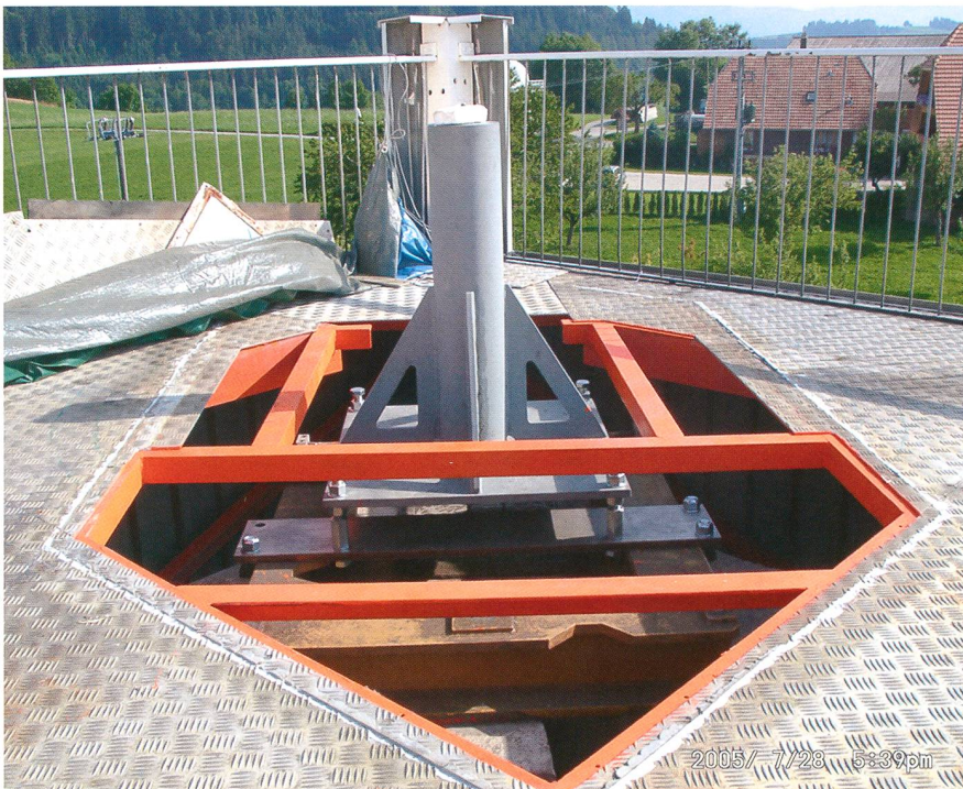
Abbildung 3: Die selbstkonstruierte Stahlsäule mit integriertem Nivelliersystem auf dem massiven, vom Rest des Gebäudes unabhängigen Instrumentensockel des Turms vor dem Aufsetzen der Clamshell Kuppel. (Bild: Thomas K. Friedli)
