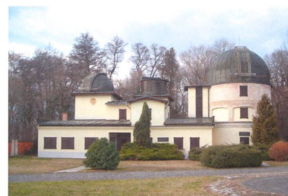
Abbildung 1: Das historische Observatorium. In der linken Kuppel ein Coudé Refraktor, rechts Cassegrain 50 cm umgebaut auf Newton. Im zentralen Teil ein Ausstellungs- und Vorführraum für Öffentlichkeitsarbeiten. Historische Instrumente sowie Ölbilder der längst verflorenen Astronomen zieren die Wände. (Bild: Christian Monstein)
