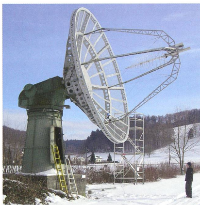
Abbildung 1: Parabolspiegel 100 MHz bis 4 GHz mit 7m Durchmesser in Bleien, Kanton Aargau.
